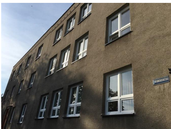
nová okna na budově Třanovského 596
